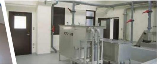
浄水場・下水処理場・揚排水機場などのインフラ施設や各種工場での高圧ガスプラントや薬品プラントの据付・配管・製作加工を行っています。
